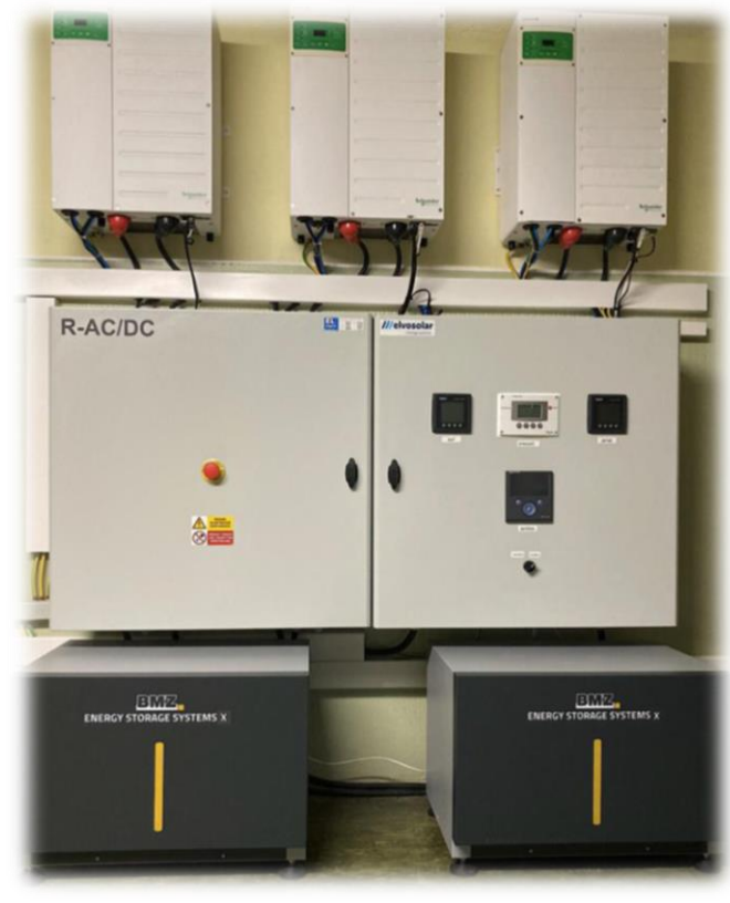
Obrázok 5 Batériový akumulčný systém
