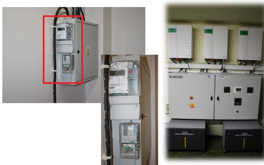
Obrázok 2 Skalár a elektromer inštalovaný v serverovni / merací bod situovaný v batériovom úložisku
