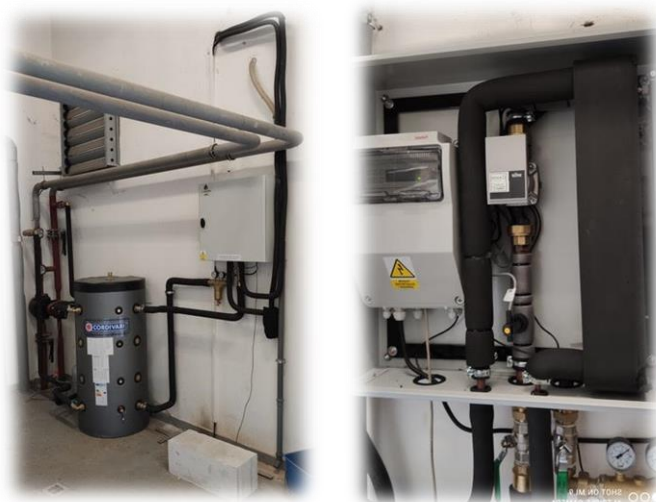
Obrázok 4 Tepelné čerpadlo
